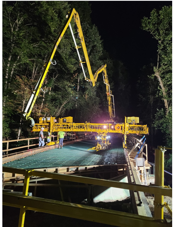
T-559-0025, Concrete Deck Pour
